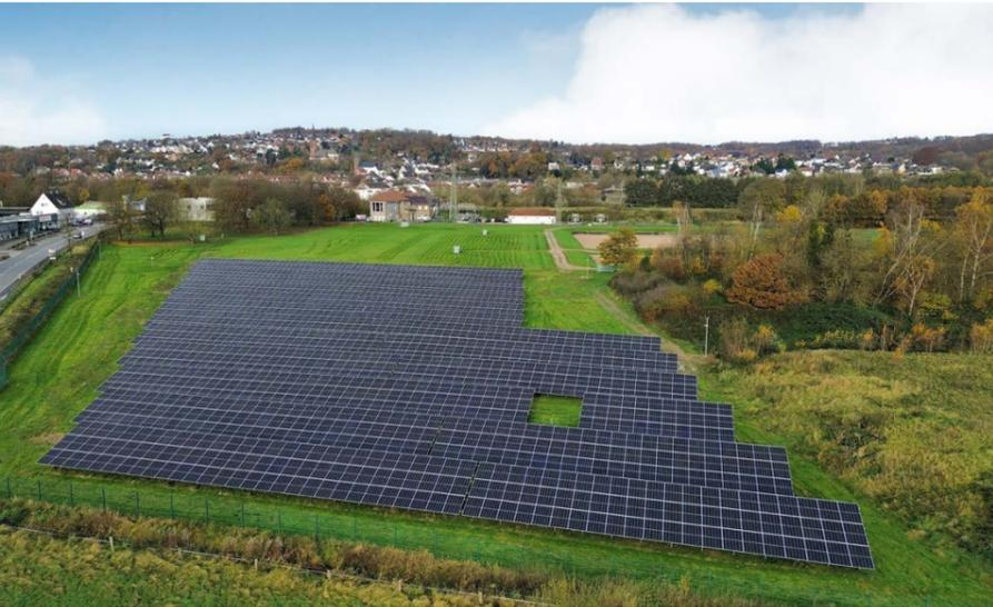
Mehr als 7.000 Quadratmeter groß ist die neue Freiflächen-PV-Anlage an der Fröndenberger Straße. Sie produziert etwa 810.000 kWh im Jahr.
